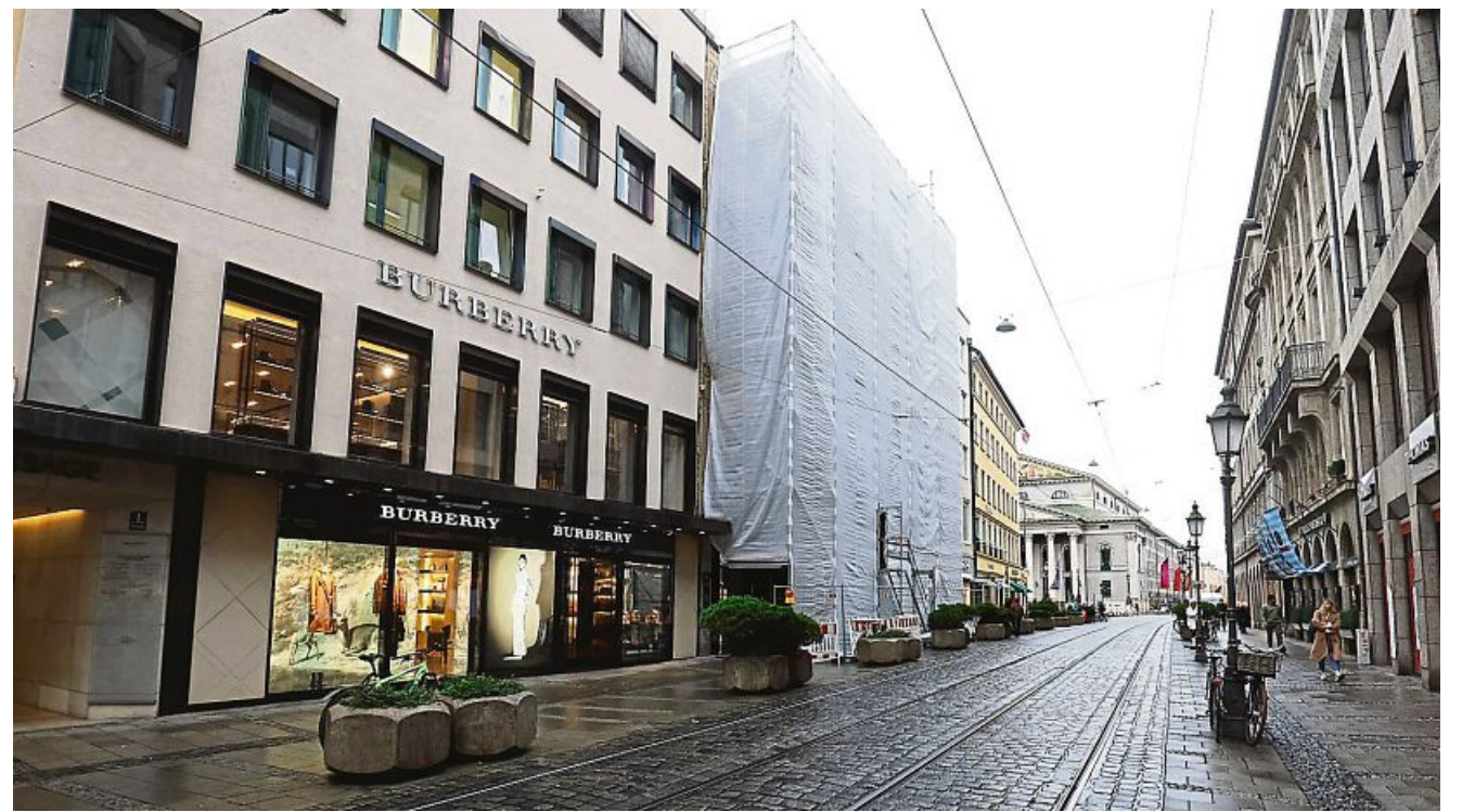
Das Gebäude an der Perusastraße 2 ist wegen Umbauarbeiten verhüllt.
